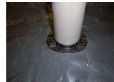
6. Passer le tuyau au travers
