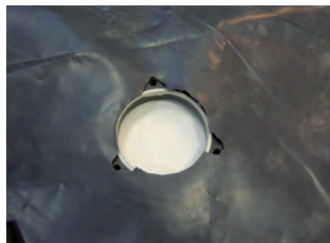
4. Découper l'emplacement des vis
