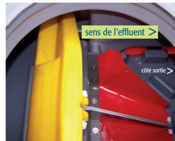
Position ouverte (Flotteur niveau haut, trappe ouverte)
